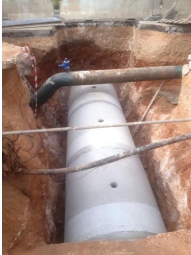
Κατασκευή αντιπλημμυρικών εργασιών στον κόμβο Θήβας
