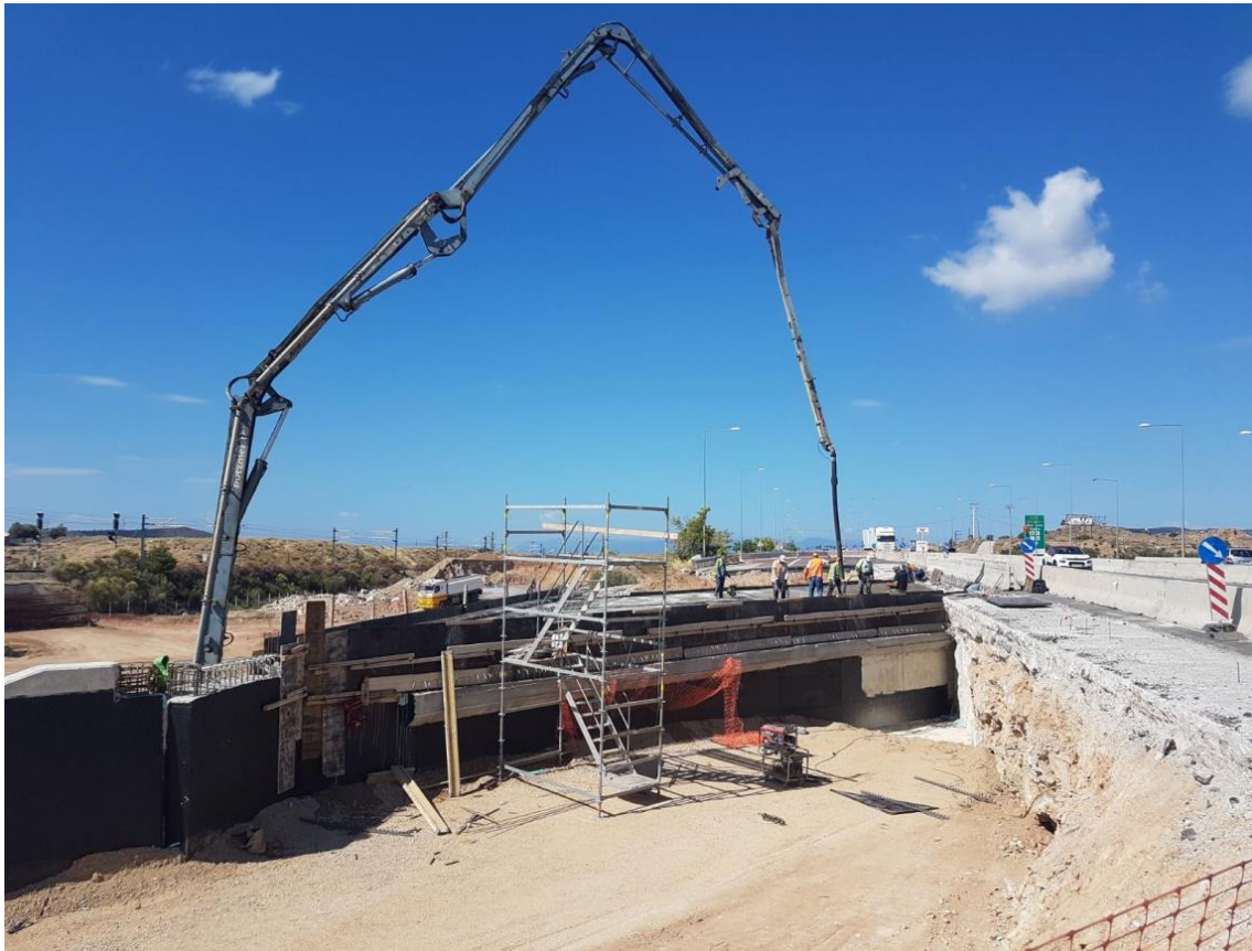
Προσωρινή στήριξη και ενίσχυση θεμελίωσης υφιστάμενων τεχνικών K007 & K008
