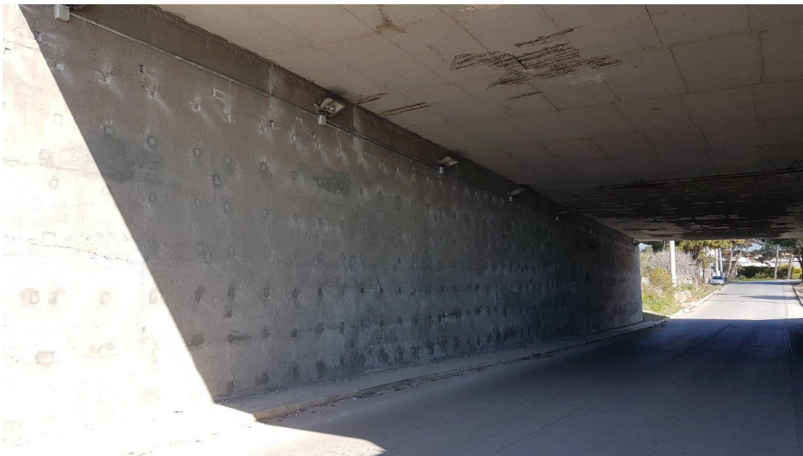
Αποκατάσταση υφιστάμενου τεχνικού
