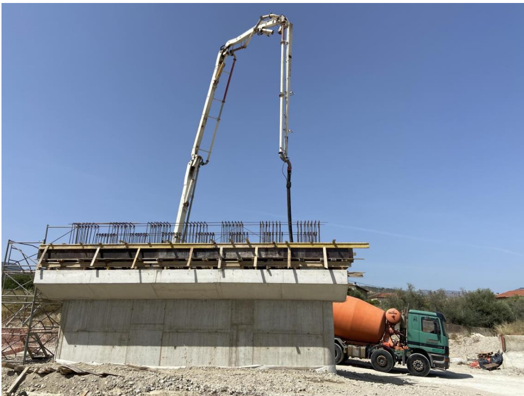
Εργασίες κατασκευής γέφυρας στον ποταμό Σύθα
